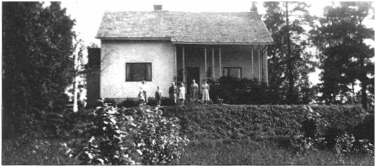
Siirtolaisperheen uudistalo Klaukkalassa sodan jälkeen.
