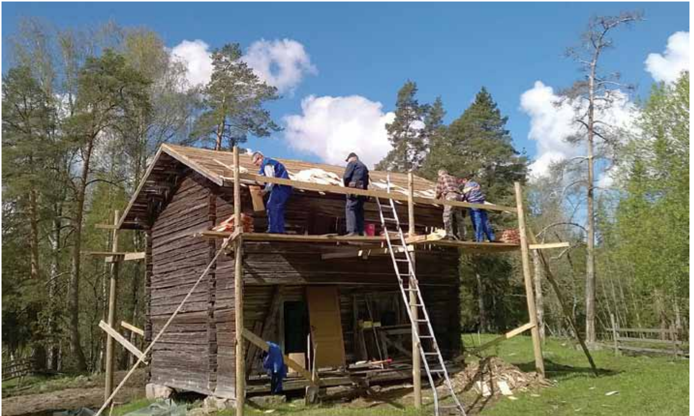
Ojakkalan aitan katon päreet naulattiin kiinni talkoilla. Parhaimmillaan kattotalkoissa oli kahdeksan nauლააჯაა.
